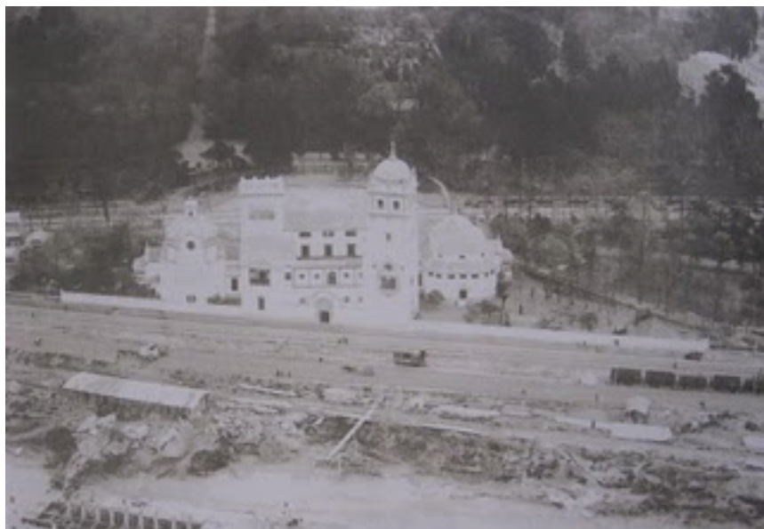
Figura 2. Pabellón argentino para la Exposición Internacional de Sevilla, 1929, M. Noel (en construcción).
